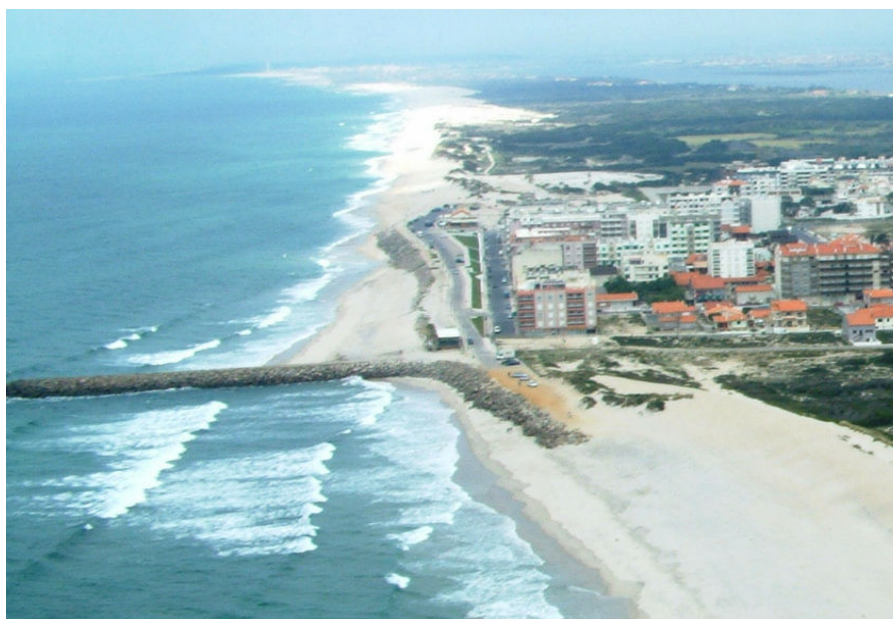
Paredão com esporão na Praia da Vagueira
