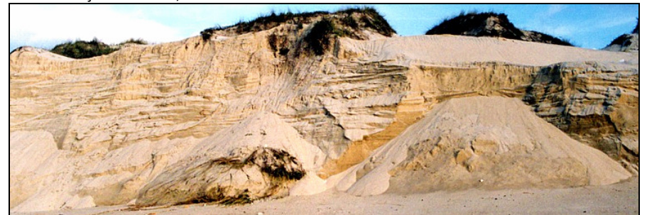
Degradação da estrutura de defesa natural com escarpa erosiva formando uma arriba viva
